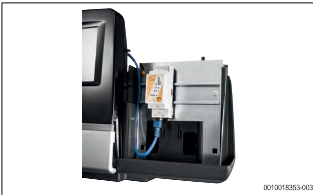
Bild 91 Montage von Bauteilen auf Hutschienenmodul
